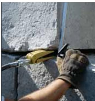
◀ *Un cilindro wedgie WR-5 es utilizado para colocar en posición un bloque de concreto en un sitio de construcción.*
