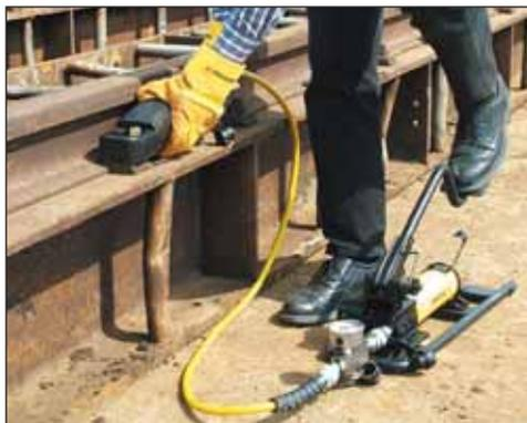
◀ La extracción fácil de tuercas herrumbrosas durante trabajos en ferrocarriles es solamente uno de los muchos ejemplos de aplicaciones del cortador de tuercas Enerpac.
