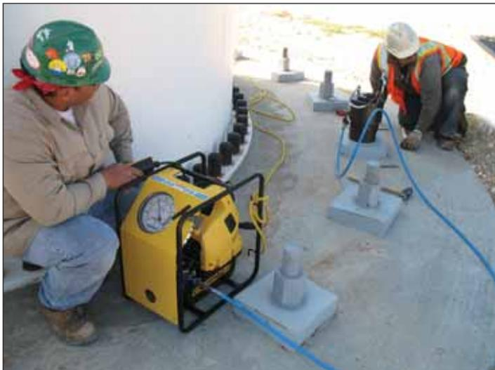
◀ En ubicaciones remotas, funcionando mediante un generador, la fiable ZUTP1500 de Enerpac entrega la presión ultra alta necesaria para aplicaciones de tensado.
