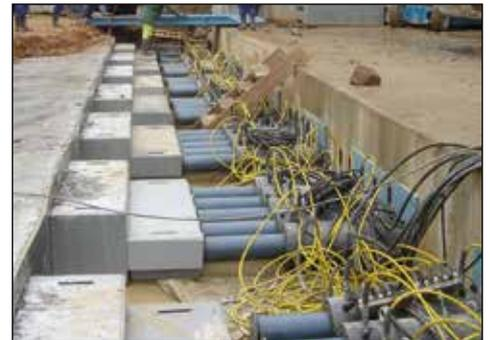
▲ Hincado de cajones: Sistema sincronizado de múltiples puntos para empujar hidráulicamente los segmentos del túnel por debajo del ferrocarril.
