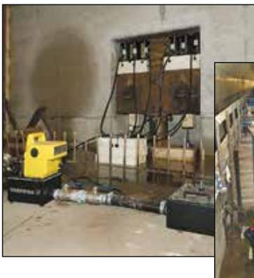
◀ Los excelentes cilindros de la serie RA de Enerpac son ligeros y están fabricados enteramente de aleación de aluminio. Los cilindros RAC-506 son ideales para el posicionamiento de elementos de túnel bajo los ríos en la línea ferroviaria de alta velocidad holandesa.
